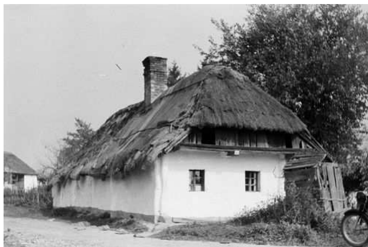
Özv. Tar Györgyné (Táncsics u. 23.) háza. Zsúptetős, csonkakontyos – eredetileg füstöskonyhás, de ma már kéményes – boronaépület. Úthosszanti épület.
